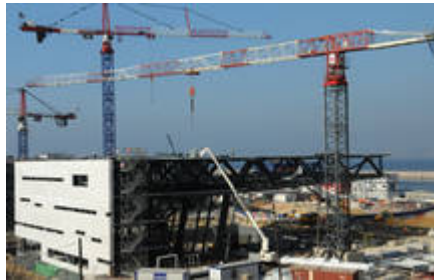
Construction du Centre Régional de la Méditerranée (CEREM)
